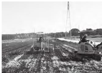
ほ場整備の様子 (池ノ内地区)
