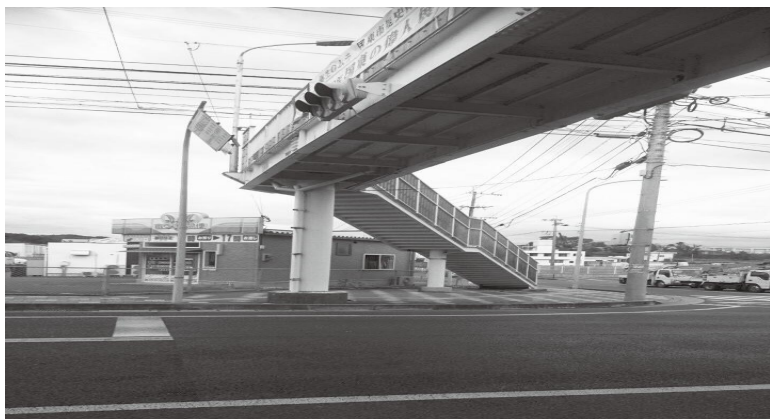
撤去が望まれる鶴川歩道橋
